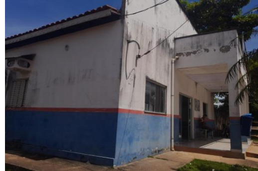
Aplicação de pintura no posto
