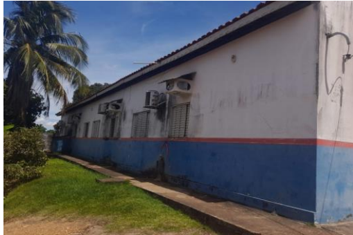
Aplicação de pintura no posto
