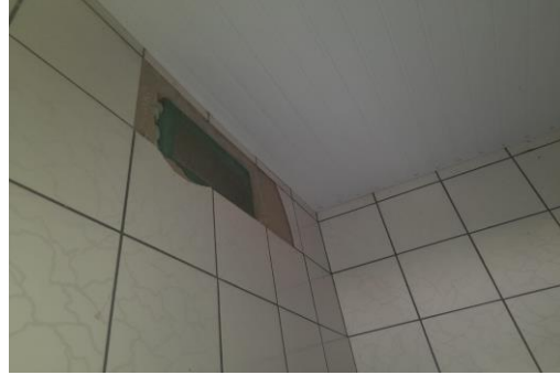
Instalação de revestimento cerâmico
