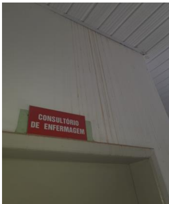
Infiltração na parede
