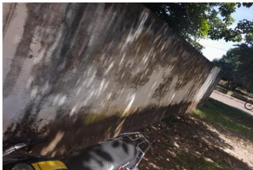
Aplicação de pintura no muro
