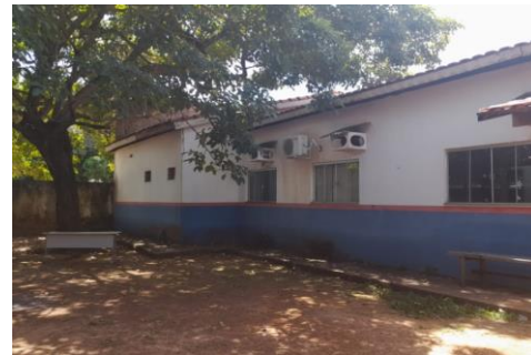
Aplicação de pintura no posto
