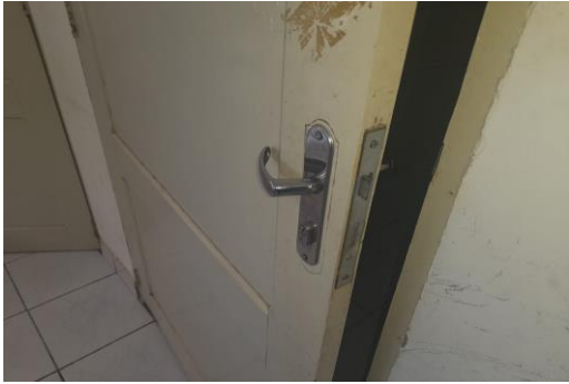
Pintura de portas
