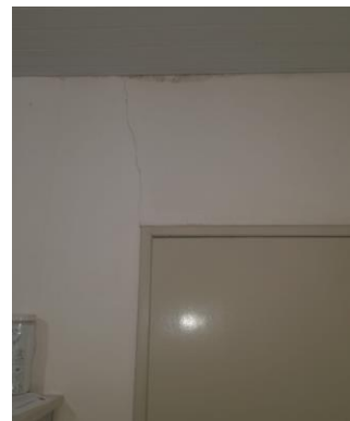
Parede com trinca
