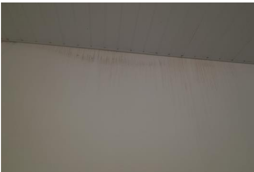
Infiltração na parede
