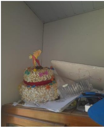
Parede com trinca
