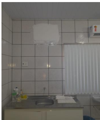
Instalação de revestimento cerâmico
