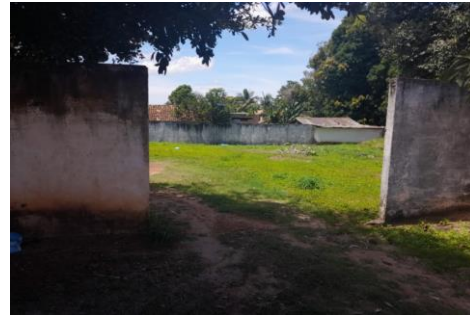
Instalação de um portão
